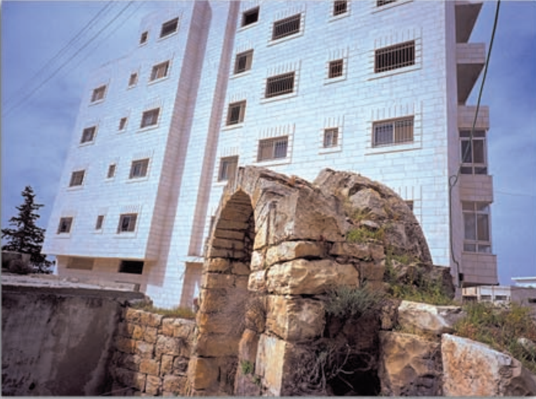
القديم والجديد في رام الله. ما لم تتم المحافظة على المباني التاريخية القديمة فسوف يتم هدمها لإقامة مبان جديدة
